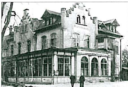
Die Gaststätte kurz vor dem Abbruch 1958
